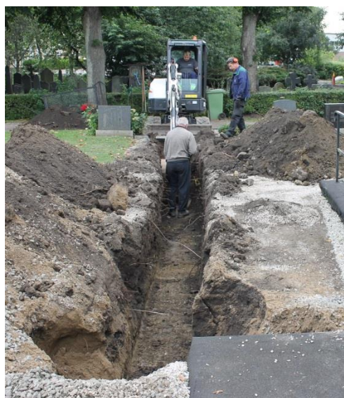
Figur 6. Schaktning från en kulvert invid Onslunda kyrka och österut Foto från väster. Foto: Lars Jönsson, Österlenarkeologi.
