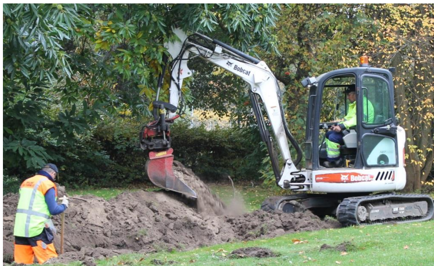
Figur 3. Schaktningen inom fastigheten Köpingebro 14:308 (Kamerala) utfördes med en bobcat. På bilden pågår schaktning för schakt 3, område 1. Foto: Daniel Lindqvist, praktikant.
