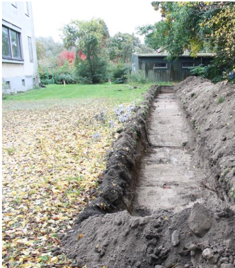
Figur 9. Schakt 3 väster om kontorsbyggnaden i den norra delen av planområdet Kamerala. Foto från norr. Foto: Lars Jönsson, Österlenarkeologi.
