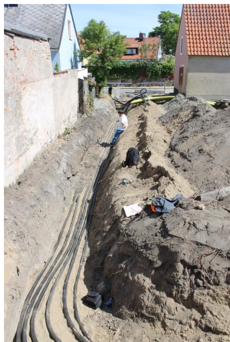
Figur 3. Översikt på en del av schaktet inom fastigheten Herden 4. I bakgrunden skymtar Östergatan. Foto från sydväst. Foto: Lars Jönsson, Österlenarkeologi.
