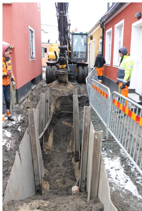
Figur 3. Schaktning pågår i den västra delen av Brunnsgatan med personal från Vallby Gräv & Schakt. På bilden syns de stora plåtskivorna som fick sättas i kanterna av schakten pga. rasrisken. Foto: Lars Jönsson, Österlenarkeologi.
